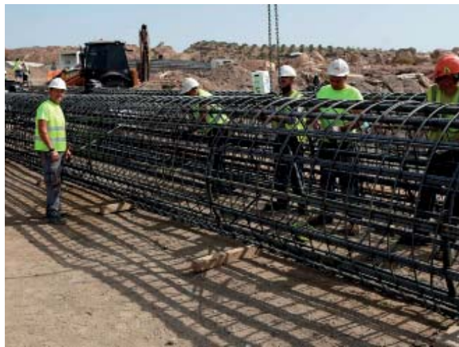
Operarios trabajan en las obras del AVE en Níjar, Almería. EFE
