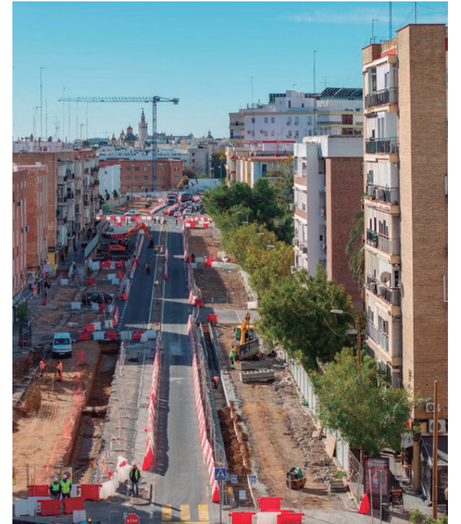
Metro de Sevilla. Línea 3 Subtramo San Lázaro-Macarena.
