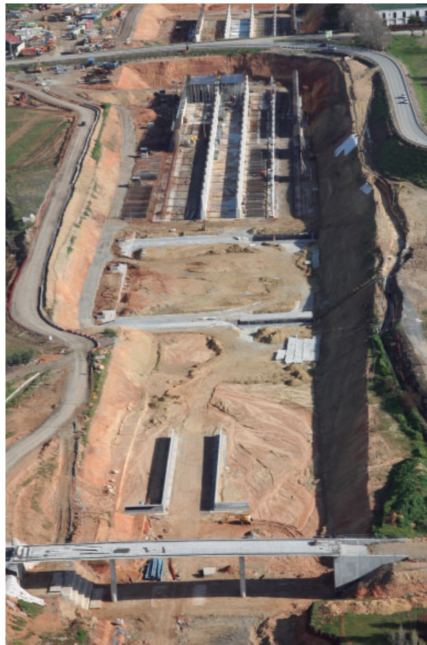
Tramo AVE Málaga-Granada.
