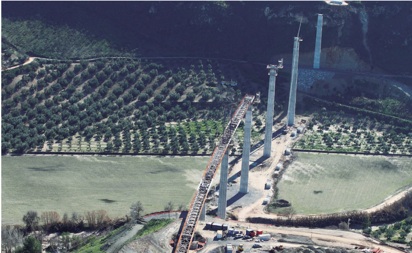
Autovía A-45. Tramo Encina Real- Benamejil.
