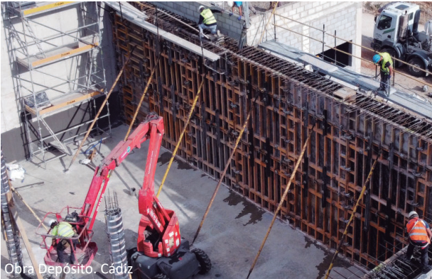
Obra Depósito. Cádiz
