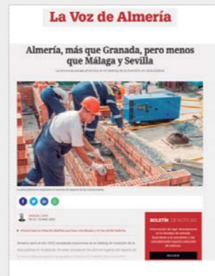
“Almería, más que Granada, pero menos que Málaga y Sevilla”
