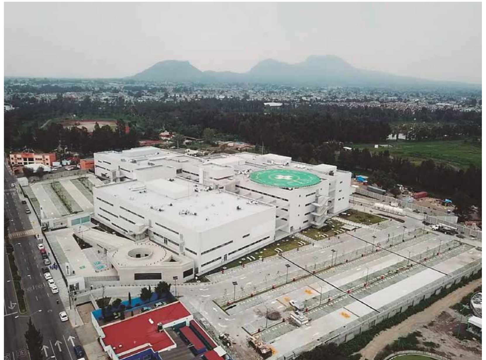
UG 21 S.L. Nuevo Hospital General Tlahuac. México
