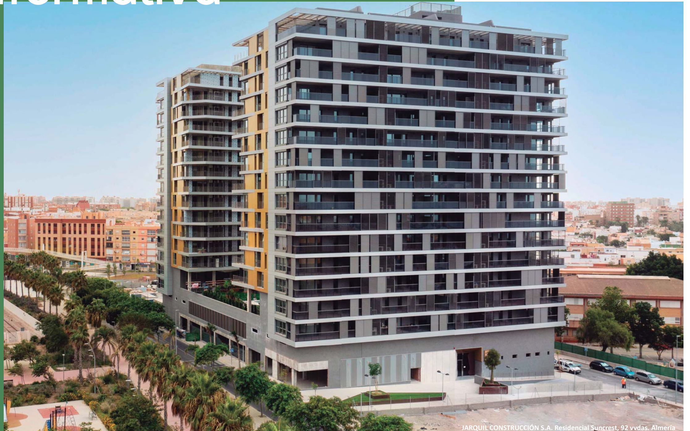
JARQUIL CONSTRUCCIÓN S.A. Residencial Suncrest, 92 vvdas. Almería
