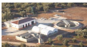
Redacción de proyecto y ejecución de colector y EDAR Villanueva del Trabuco (Málaga)
