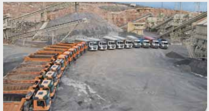
▲ Extracción de 1.500.000 m 3 de tierra para la construcción de la infraestructura ferroviaria para el AVE
